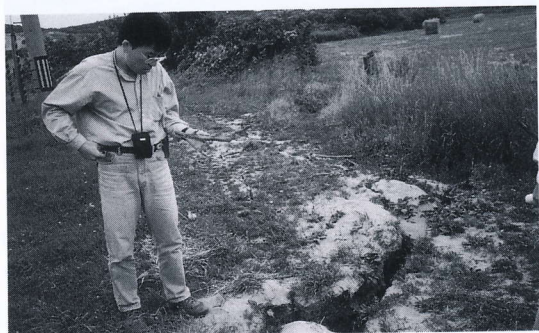
写真 4.3.2 牧草地に発生した亀裂 Cracks on pasture
