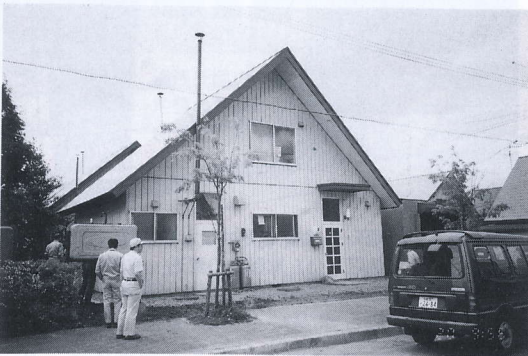
写真 4.4.38 今金町商工団地の被害 住家は全体に15cm沈下し、排水に支障を生じた House settled by 15 cm, resulting in ill drainage (Imakane town)
