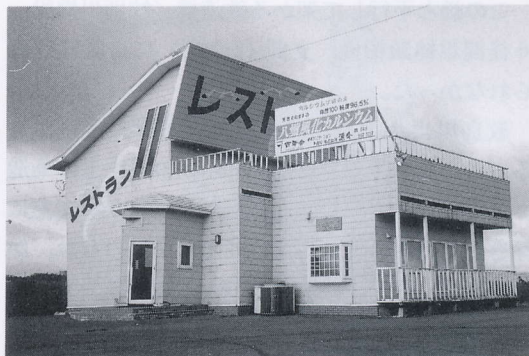
写真 4.10.12 紋別橋直ぐ北のドライブインの被害(1) 盛土上に築造されていて、傾斜、変形した Distorted restaurant on earth-fill (1)
