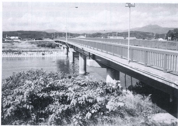
写真 4.8.6 基栄橋 The Motoe bridge
