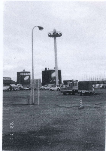
写真 4.9.20 東日本フェリーターミナルの被害(8) 照明灯の傾斜 Tilted light pole (H.N.F.T) (8)
