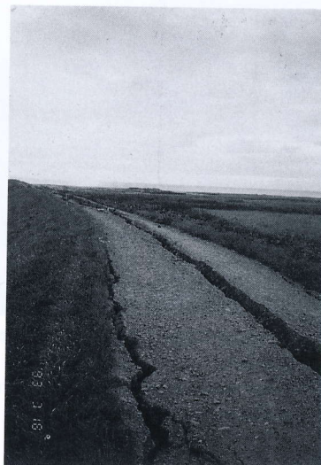
写真 4.3.13 後志利別川河口部左岸堤防の被害 (1) Longitudinal cracks on embankment (Shiribeshitoshibetsu river) (1)
