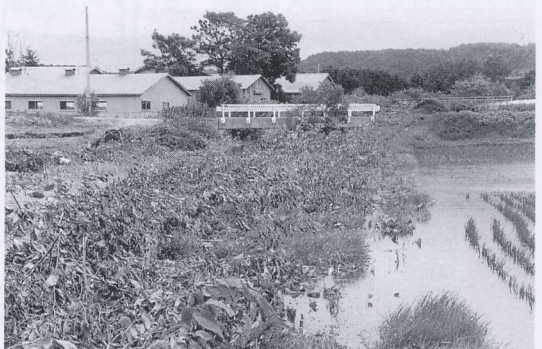
写真 4.4.26 今金町豊田の農道の被害 (5) 農道と川の間は田圃の一部は沈下し、水位の上昇のため冠水 Upheaval of riverbed resulted in submergence of rice field. (5)
