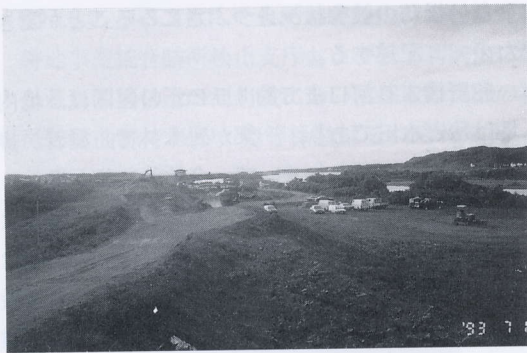
写真 4.3.7 兜野橋袂からみた後志利別川河口部 堤外地へ下る工事用道路がみえる View of estuary of Shiribeshitoshibetu river from Kabutono bridge
