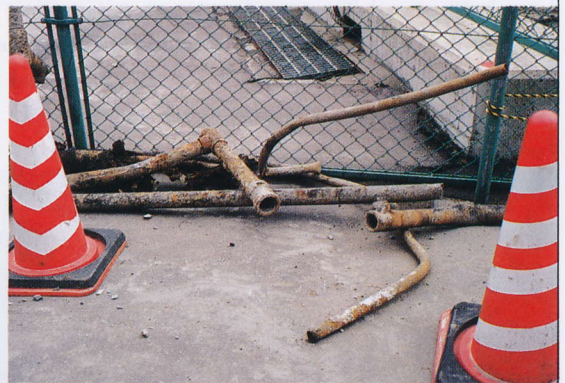
写真 4.9.4 掘り出された管類 Bent pipes, Sea Port Plaza
