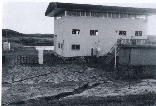
写真 4.3.13 後志利別川河口部左岸堤防の被害 (1) Longitudinal cracks on embankment (Shiribeshitoshibetsu river) (1)
