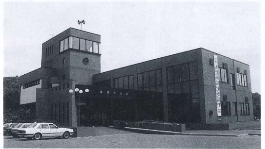
写真 4.2.11 無被害の瀬棚町役場 ここでは僅か掘るだけで岩盤に達する Setana town hall built on the rock gro- und (No damage was reported.)
