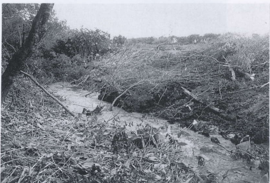
写真 4.4.32 今金町豊田の農道の被害(11) 当該地域の川の下流端には、狭められた川 幅を開削し、川底を掘削して、水を流した 跡がある Cut work for discharge of pooled water (11)
