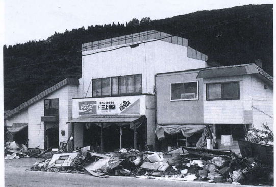
写真 4.8.1 大成町の津波の被害(1) 大破した家は既に取りこわされている Totally collapsed and partially damaged houses due to tsunami attack (Taisei town) (1)
