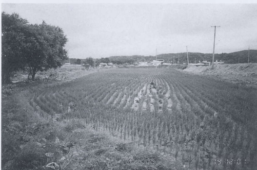
写真 4.4.25 今金町豊田の農道の被害 (4) 農道と川の間は田圃に生じたクラック Cracks on the rice-field between the road and channel (left side) (4)
