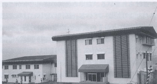
写真 4.4.6 太櫛荘 3階の建物は外見上は被害は認められない 基礎が良好なことが影響しているものとみられる Futoro-hotel built on the hard ground. No damage was found
