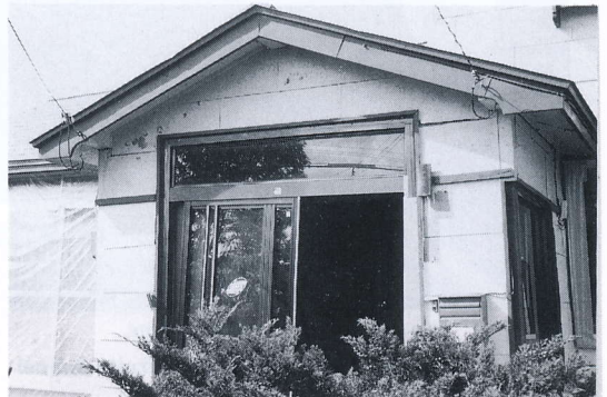
写真 4.2.12 地震により大きな被害を受けた民家(1) (旧河川跡造成地に建築されている) Severely damaged house on the re- claimed ground (1)
