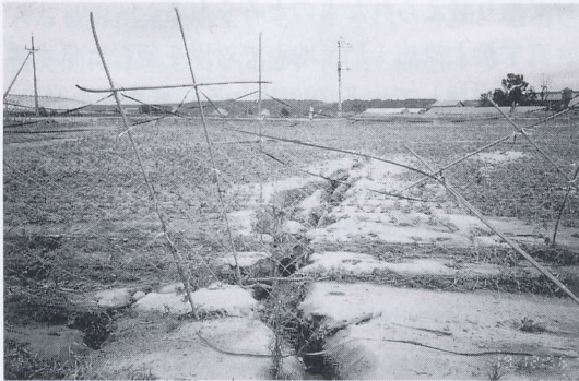
写真 4.4.29 今金町豊田の農道の被害(8) 右岸側畑地に発生した亀裂 Cracks and spouted sand near the channel (8)
