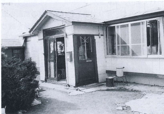
写真 4.2.13 地震により大きな被害を受けた民家(2) (正面玄関が左へ傾き、玄関周辺のコンクリート板には亀裂が入っている) Severely damaged house on the re-claimed ground (2)
