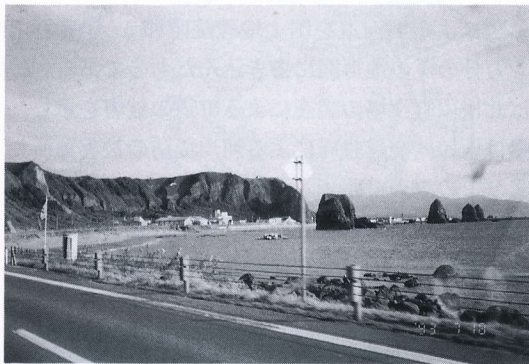
写真 4.2.17 3本杉岩の北の海岸線 狭隘な土地に家屋・道路が建設されている Seashore extending north of the Sanbonsugi
