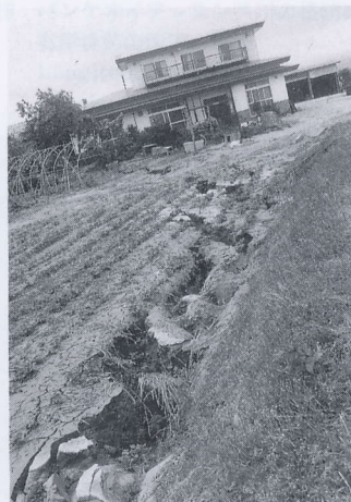
写真 4.4.28 今金町豊田の農道の被害 (7) 右岸側、川より数 10 m の範囲で表層が河心に向かって移動 Lateral spread of surface ground along the channel (7)
