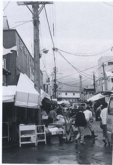
写真 4.9.9 正午の朝市 写真の左側が約 1 m 沈下し電柱が沈下した。 その後埋立て修復された。左側部の埋立時期 が相対的に新しい “Asaichi” market near Sea Port Plaza. Left side of road has sunken by about 1 meter. This part is the latest reclaimed land among the others.
