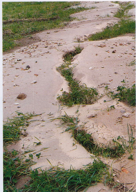
写真 4. 4. 20 砂利を含んだ噴砂があった 噴砂孔列 (後志利別川左岸高水敷) (2) Liquefaction on the left river bed of Shiribeshitoshibetsu river (2)
